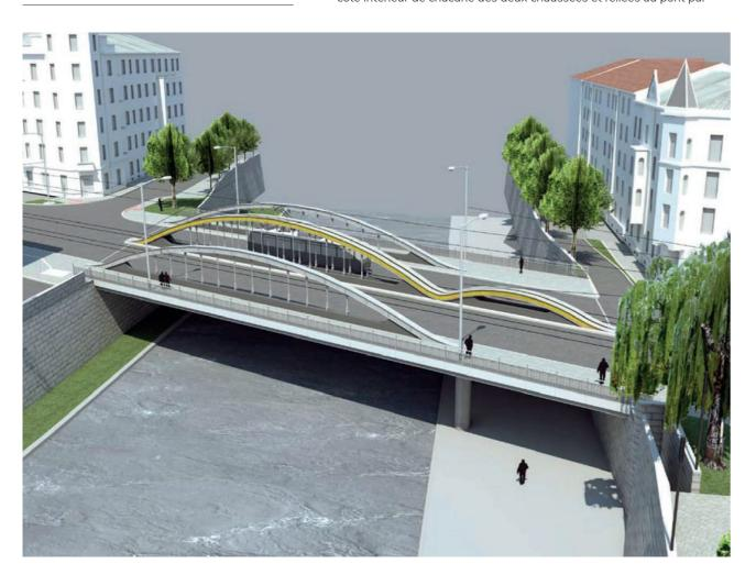
des barres métalliques de 60 mm de diamètre. La structure globale est large de 26 mètres et longue de 55 mètres. Son installation a eu lieu à deux moments différents pour éviter l'interruption du trafic, une chaussée à la fois : d'abord une rue du pont existant a été démolie, puis les nouvelles
